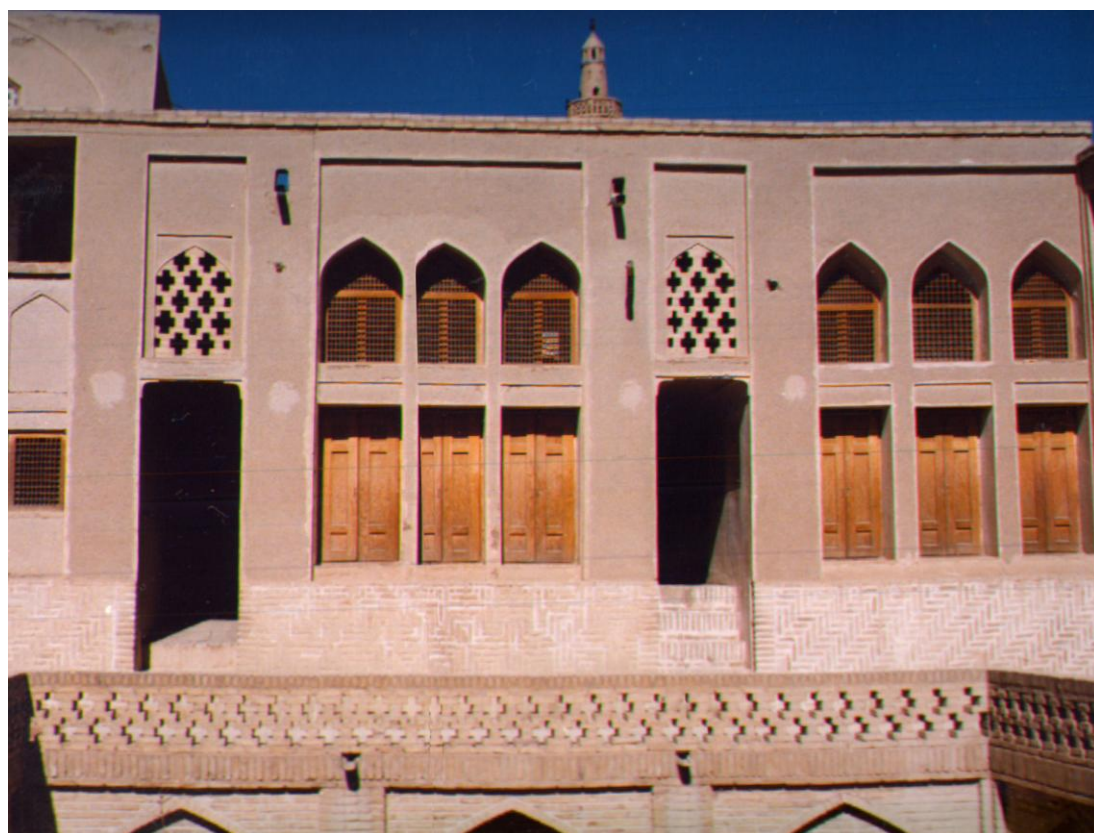
نصب شبکه عایق در پشت پنجره‌ها میزان تبادل حرارت فضای داخلی ساختمان و محیط اطراف را کاهش می‌دهد
