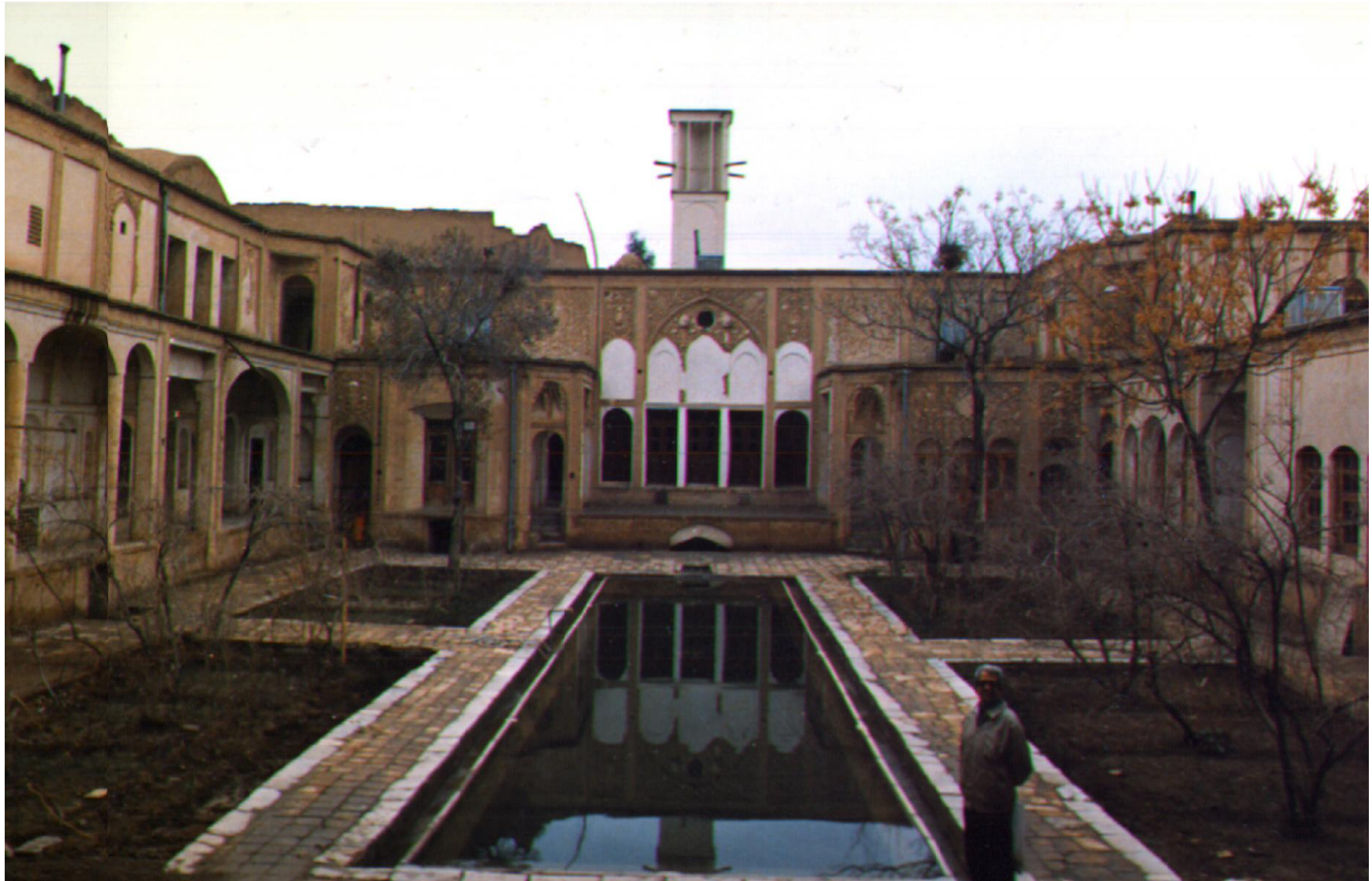
ساختمان‌های حیاط مرکزی قادرند از طریق حفظ رطوبت ایجاد شده در سطوح عناصر محوطه رطوبت هوای محیط را افزایش دهند (خانه بروجردی‌ها در کاشان)
